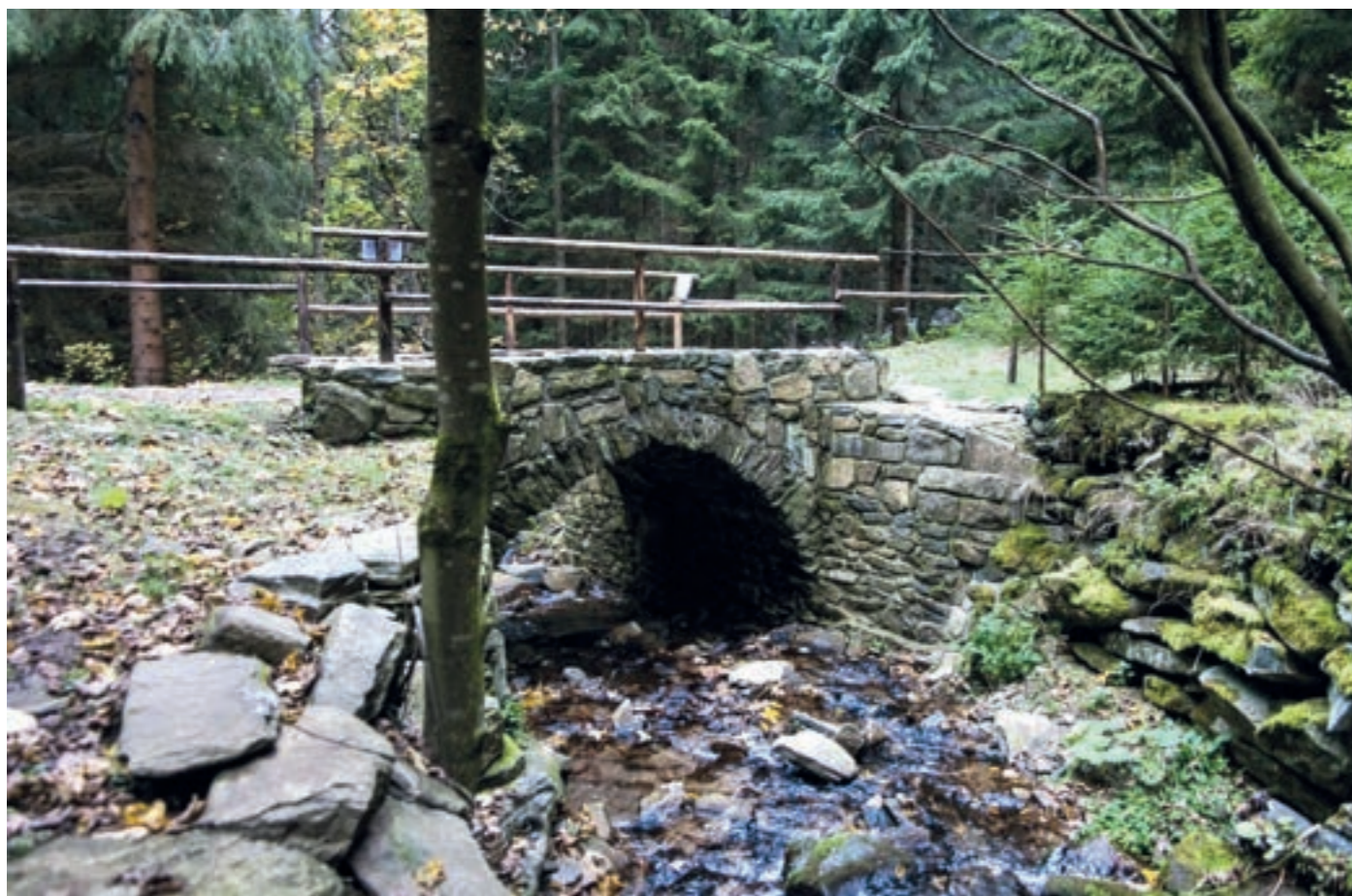
Kamenný most přes Hučavu po opravě
