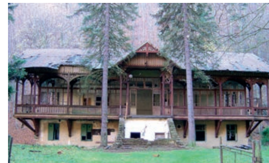
Tančírna před opravou (foto: rychleby.cz)
