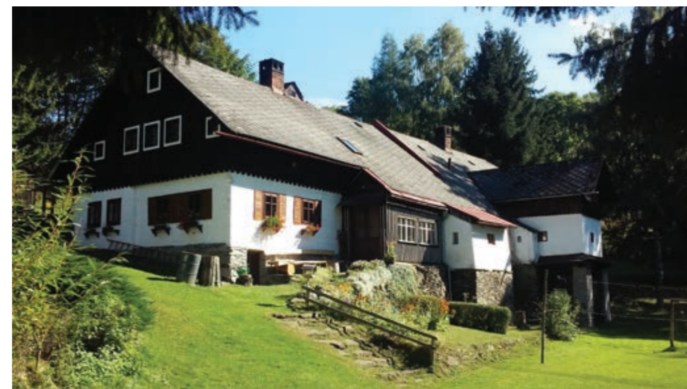
Branná – unikátní zachovalý objekt typické jesenické podhorské architektury, chalupa udržovaná osvětlenými chalupáři, hojně užit tradiční stavební materiál místní kámen a dřevo, bez cizorodých stavebních materiálů.
